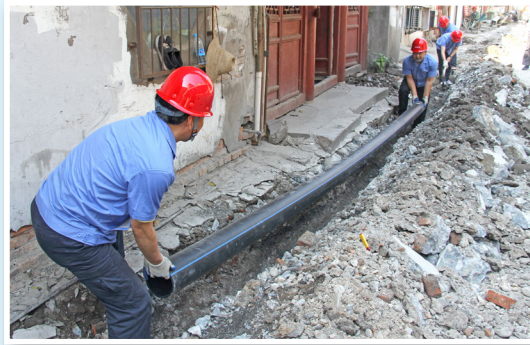
近日，集团公司投资 18 万元对五星三村局部供水管网改造 200 米，现改造完成，并顺利通水。
