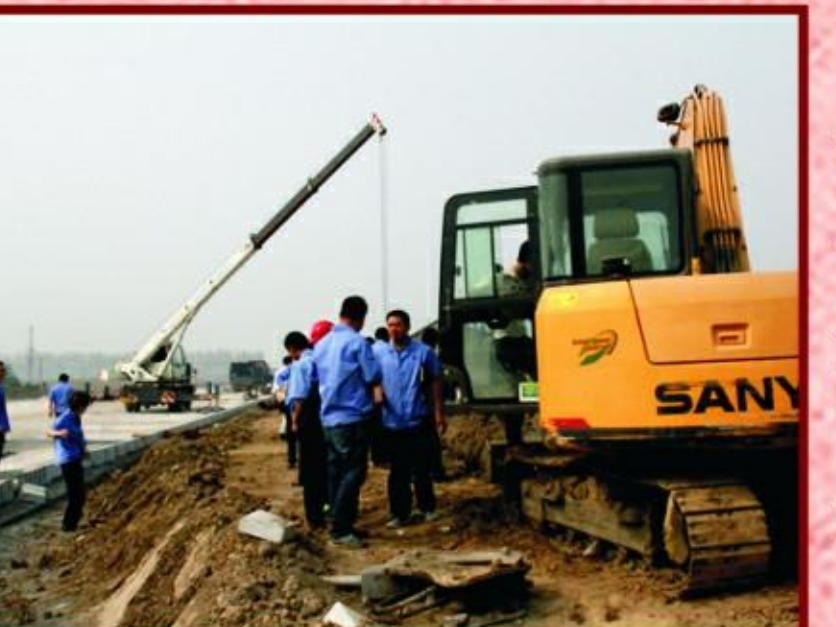
临港工业新城疏港大道给水工程
