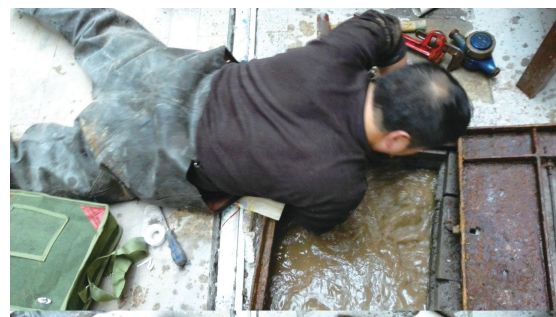
南湖客服中心维修员正在抢修漏水点。
